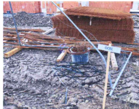
Obr. 2 Príklady triedenia stavebných odpadov pri realizovanej stavebnej činnosti
