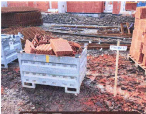
Obr. 2 Príklady triedenia stavebných odpadov pri realizovanej stavebnej činnosti
